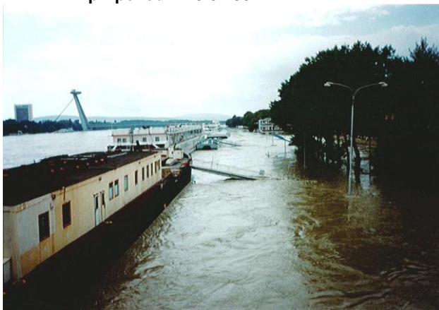
Obr. 11 Zaplavený osobný prístav v Bratislave pri povodni 15.8.2002
