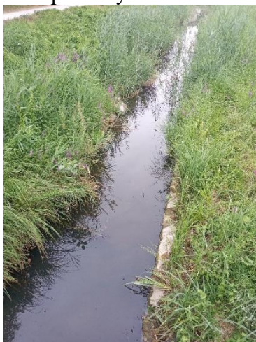
Rudavka – napriamené koryto so spevnenými brehmi
