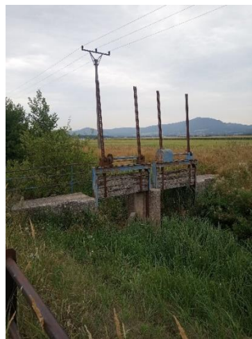
Rudavka – nefunkčná priečna stavba
