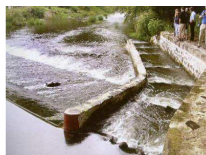
c) Kamenný stupeň s rybovodom
